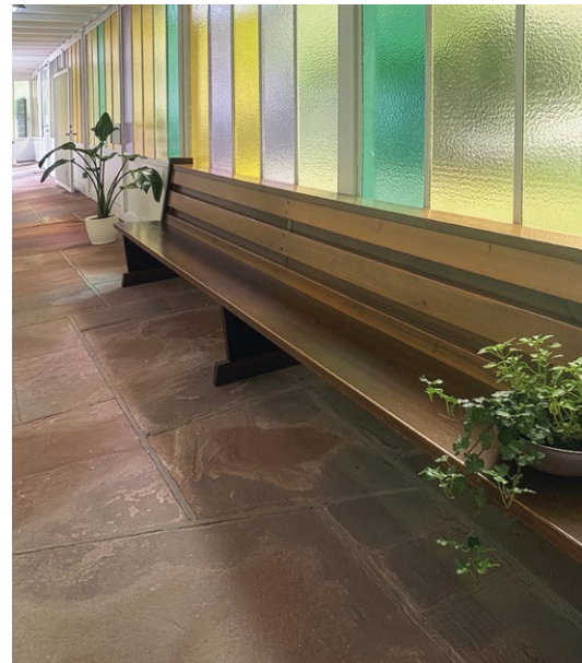
Die ehemaligen Kapellenbänke wurden im Sinne des Upcyclings zu ansprechenden Sitzgelegenheiten innerhalb der Einrichtung eingesetzt.
